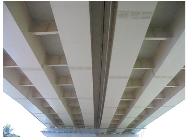
거더(S.T.B), 바닥판하면 전경
