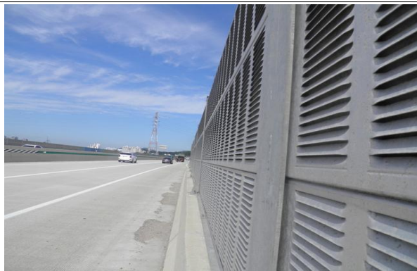
방호벽, 방음벽 전경
