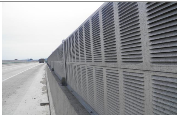
방호벽, 방음벽 전경
