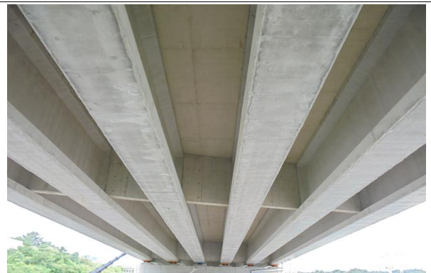
거더, 바닥판하면 전경
