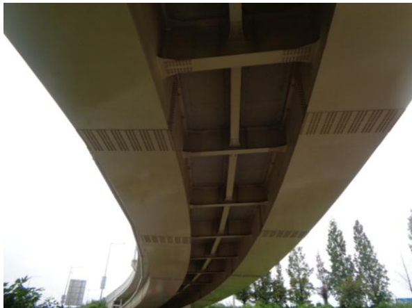
거더외부, 바닥판하면 전경
